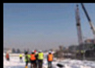
Sede Unica della Regione: palo pilota
